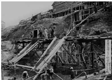
〈사진 2〉 1940년 슈마리나이댐 공사 현장 (© 동아시아 시민네트워크)
